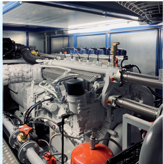
foto: Detail warmtekrachtkoppelinginstallatie
